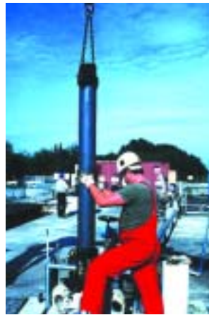
Einbau der Pumpe in der Geothermiebohrung Bruchsal
