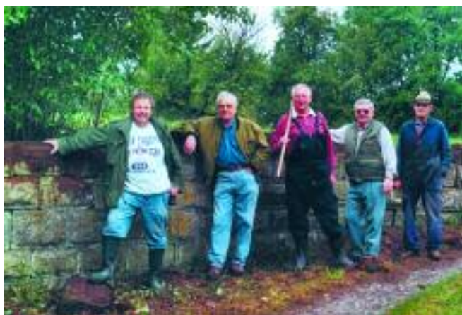
Diese sauber gearbeitete Weinbergmauer wurde von der OG Öhringen in mühevoller Arbeit wieder hergerichtet.
