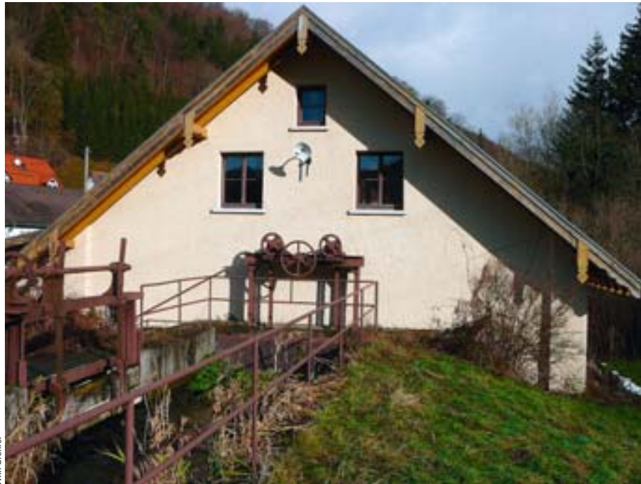
Willy Stiehler Pumpwerk Teuringshofen
