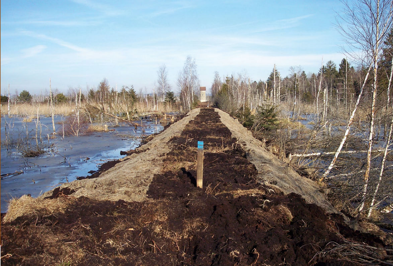
Staubauwerken an einem Torfstich im Wurzacher Ried. Der Rückstau von Wasser führt zur Wiedervernässung der trockenen Torfkörper.
